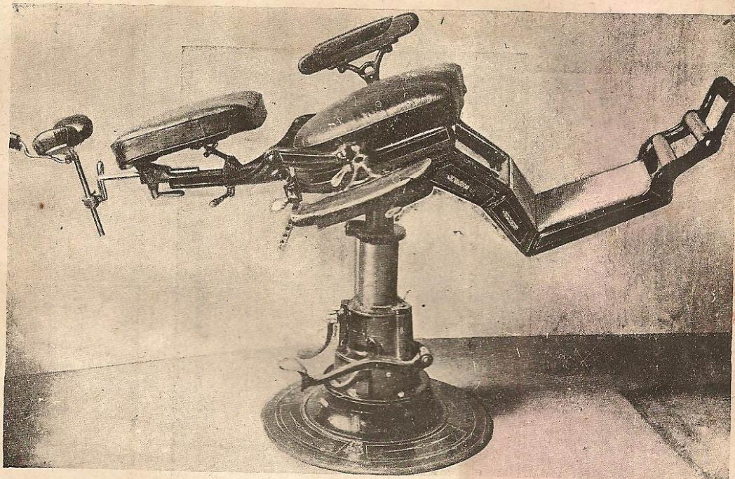
Нажатием рычага спинка кресла приводится в совершенно горизонтальное положение. Ручки кресла могут быть опущены и зажатием рычага установлены в любом положении. Имеется особая подножка для детей.
