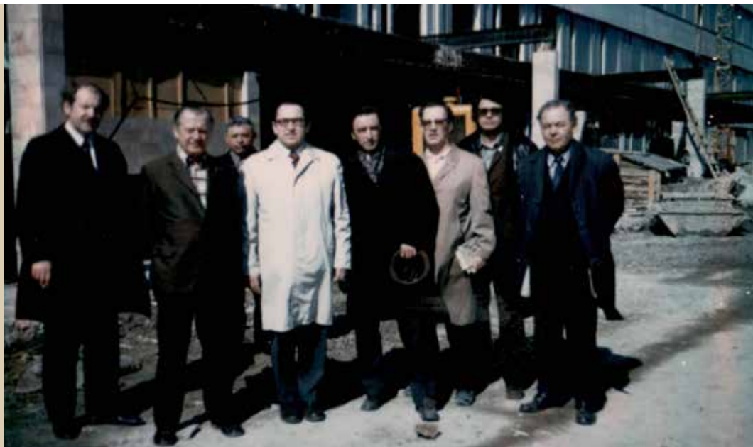
Г.Н. Троянский, В.Н. Копейкин и ректор ММСИ К.М. Лакин на строительстве стоматологического комплекса ММСИ на ул. Вучетича. 1976 г. Из собрания Музея истории медицины Российского университета медицины.
